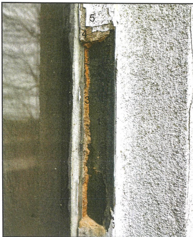
Fot.nr 14 Odkrywka sondażowa okna elewacji południowej.
