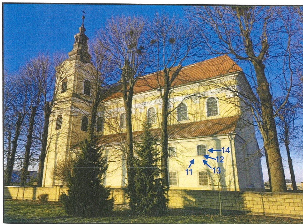
Fot. nr 22 Lokalizacja odkrywek na elewacji południowej.
