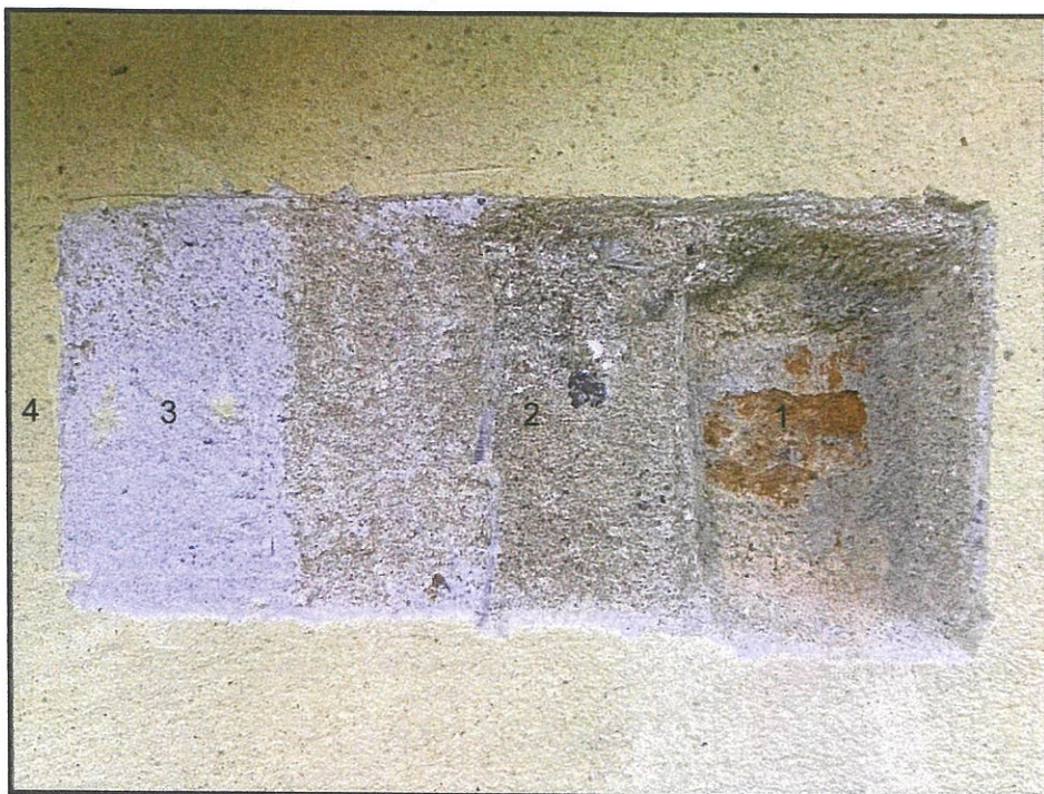
Fot.nr 3 Odkrywka sondażowa tynku elewacji frontowej (zachodniej).
