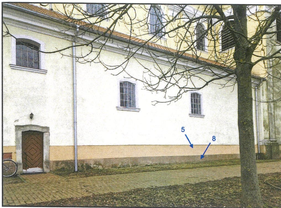
Fot. nr 21 Lokalizacja odkrywek na elewacji północnej.
