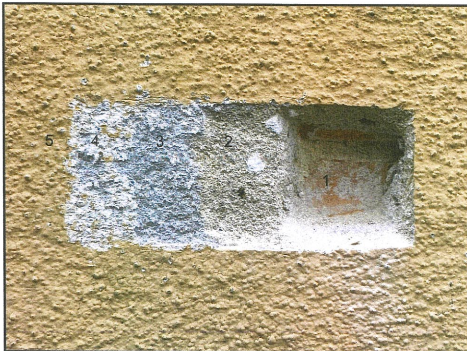
Fot.nr 5 Odkrywka sondażowa wyprawy tynkarskiej elewacji północnej.
