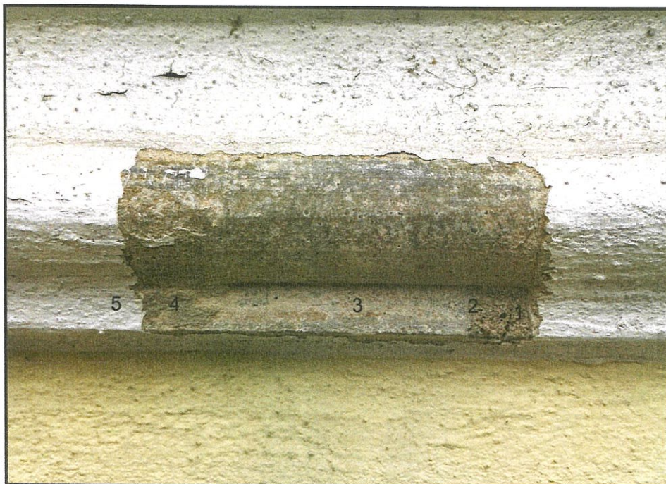
Fot.nr 13 Odkrywka belkowania okna na elewacji południowej.
