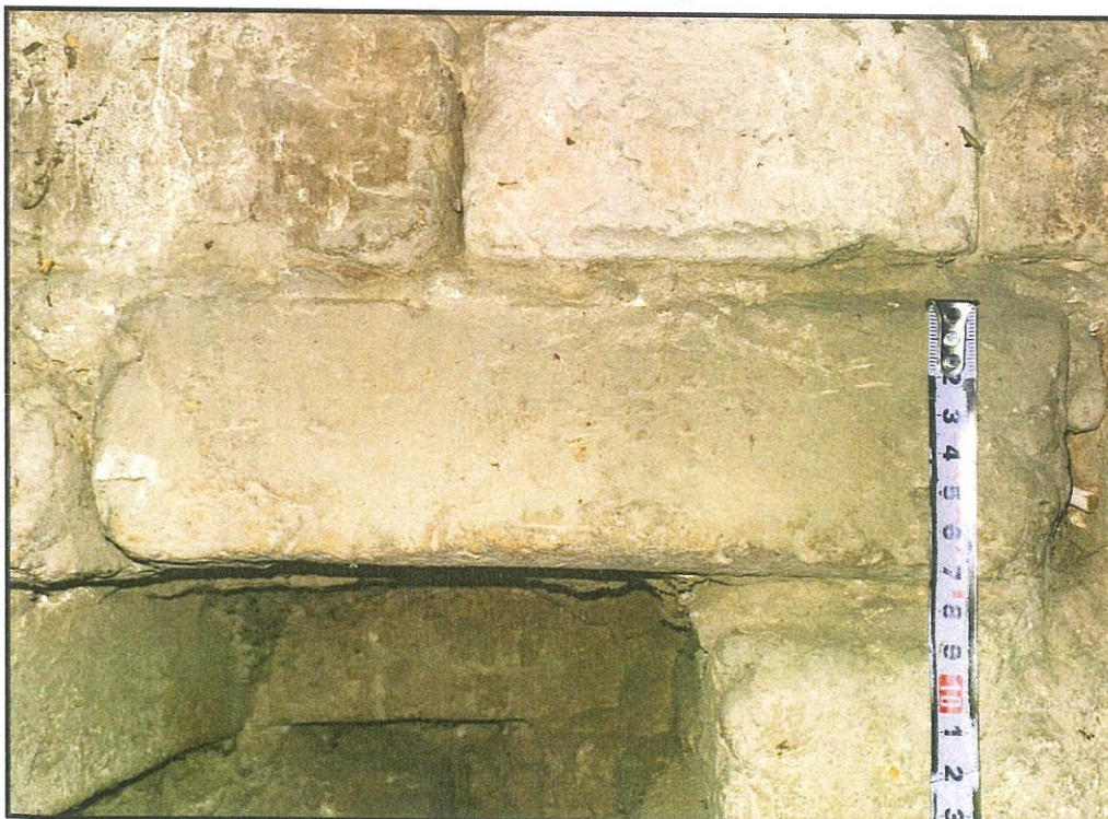
Fot. nr 16 Odkrywka muru ceglano. Wymiary cegły 24 cm x 7 cm.
