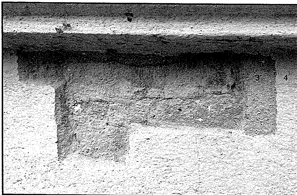
Fot.nr 6 Odkrywka sondażowa wyprawy tynkarskiej elewacji północnej pod opaską okienną.
