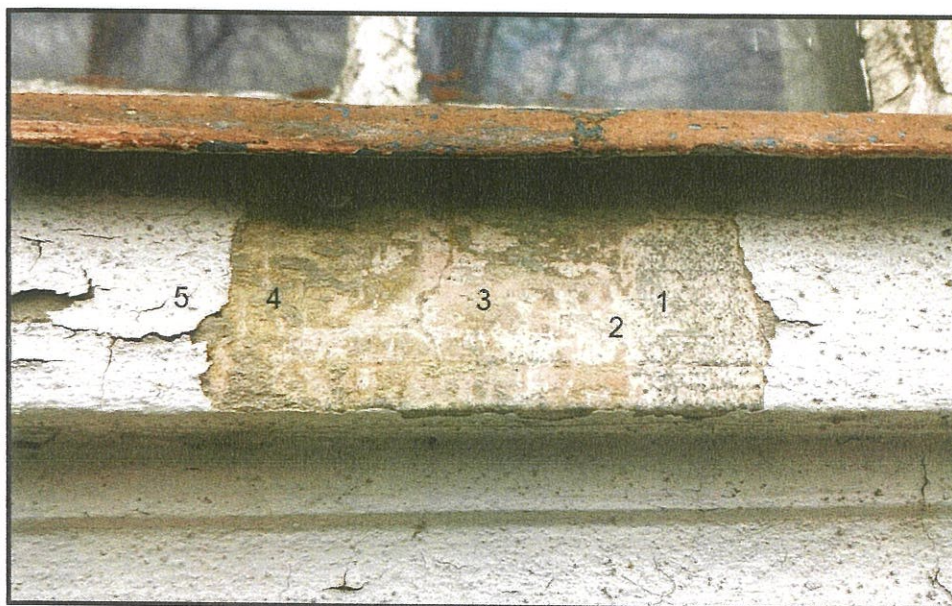
Fot.nr 12 Odkrywka belkowania okna na elewacji południowej.
