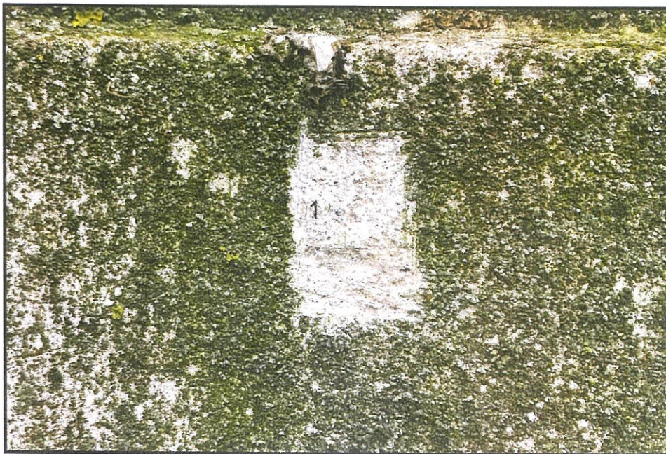
Fot.nr 7 Odkrywka sondażowa detalu architektonicznego elewacji północnej.
