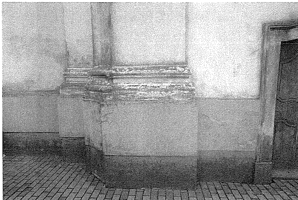
Fot. 3. Korozja biologiczna w postaci glonów i porostów, korozja chemiczna i w pewnym stopniu mrozowa
