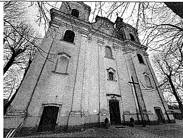
Zd.1 Widok elewacji zachodniej
