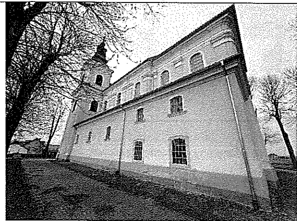
Zd.3 Widok elewacji południowej
