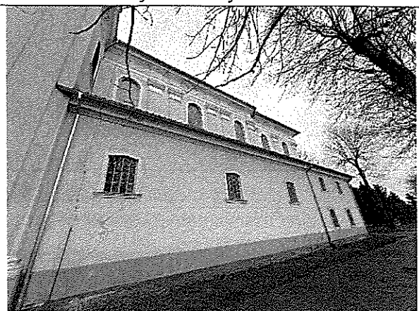
Zd.4 Widok elewacji południowej
