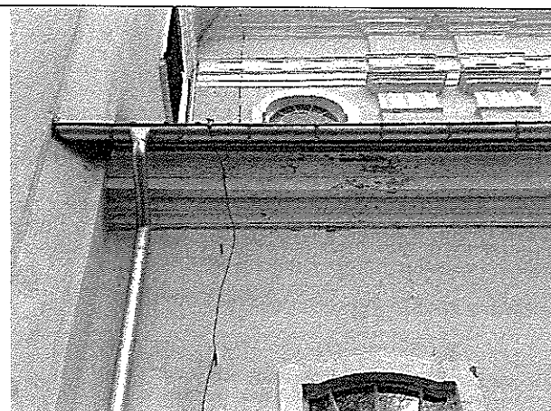
Zd.40 Widok gzymsu po stronie południowej.
