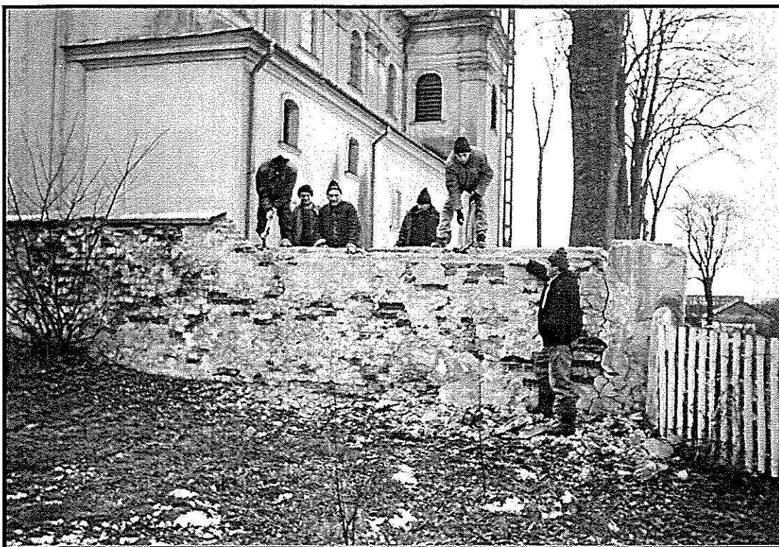
Fot 6. Zdjęcie archiwalne przedstawiające remont muru w 2003 roku. W tle widoczne niemalowane tynki.
