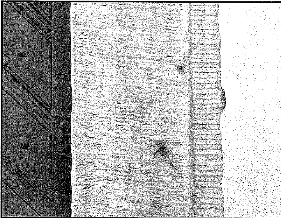
Fot. 43. Zachowane ślady uszkodzeń kamienia pochodzące z okresu I Wojny Światowej (powstały w wyniku ostrzału lub odłamków granatu).
