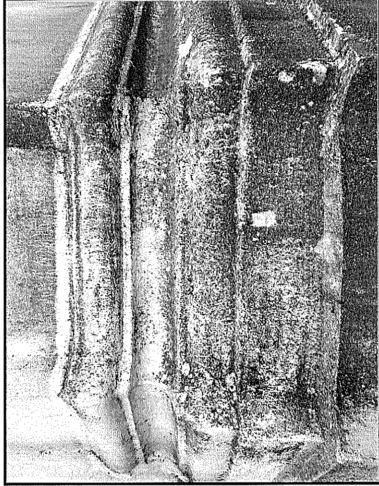
Fot. 45. Stan zachowania detalu architektonicznego (bazy pilastra elewacji północnej).
