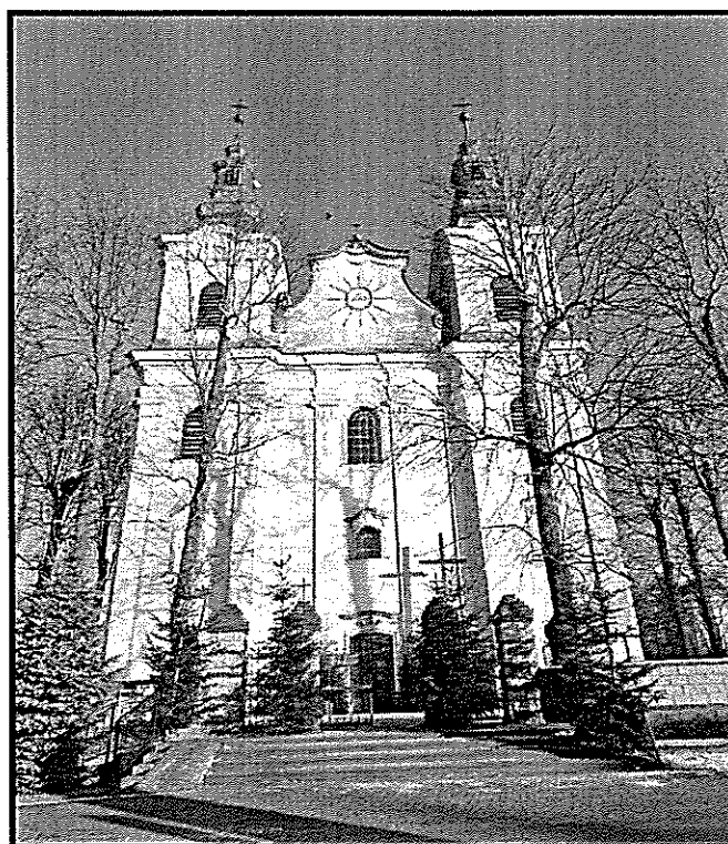
Fot. 11. Stan zachowania elewacji frontowej (zachodniej) kościoła w Regnowie.
