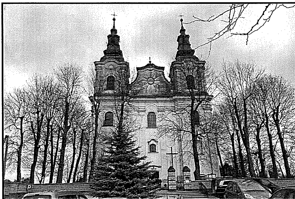
Fot. 12. Stan zachowania elewacji frontowej (zachodniej) kościoła w Regnowie.
