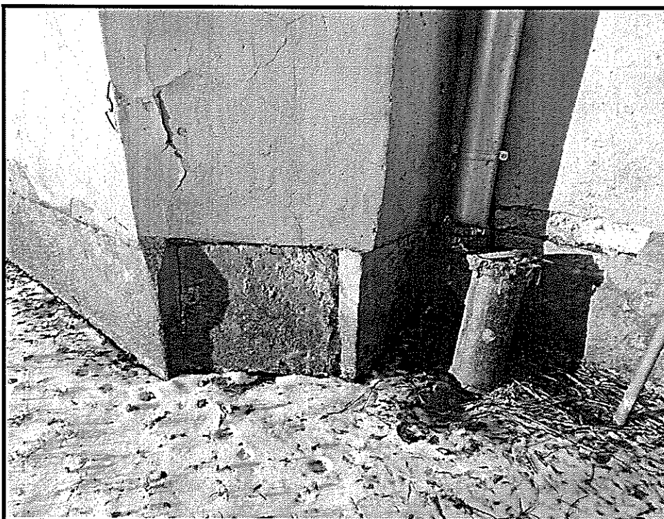
Fot. 60. Widoczna niedrożna rura spustowa (zatkana w wyniku zebrania się w rynnach obumarłych liści i patyków z pobliskich drzew).
